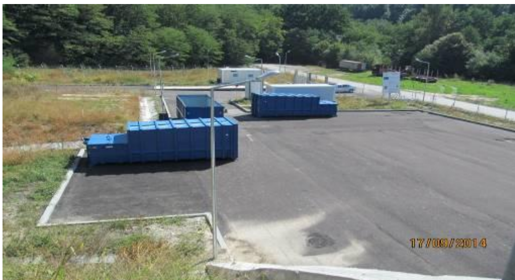
Fig. VII.1.5. Stația de transfer deșeuri din Surduc
