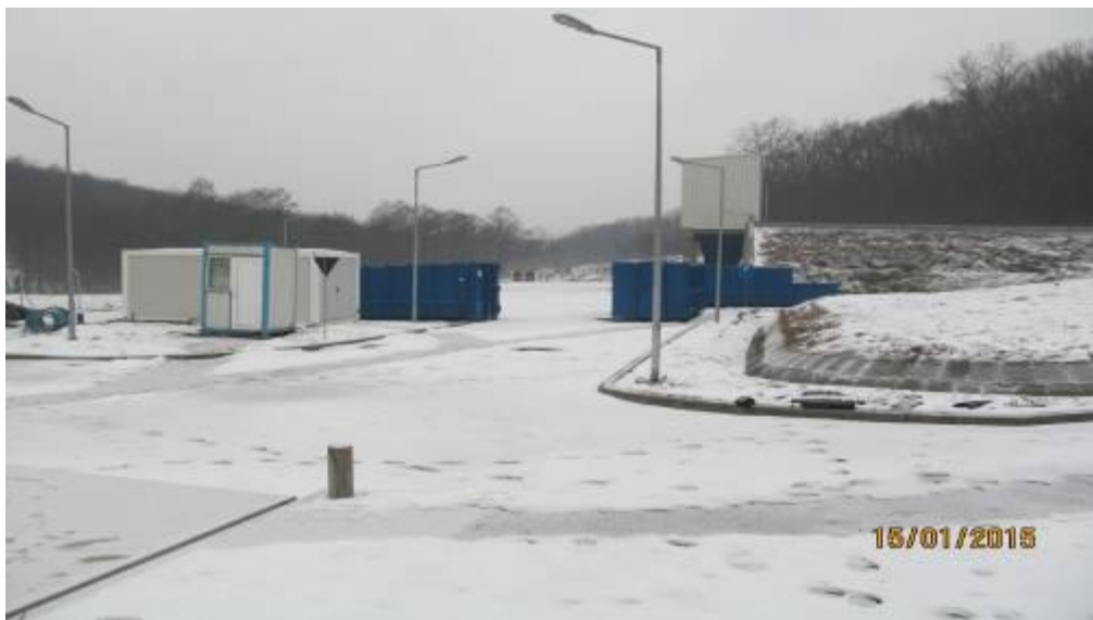
Fig. VII.1.4. Stația de transfer deșeuri din Surduc
