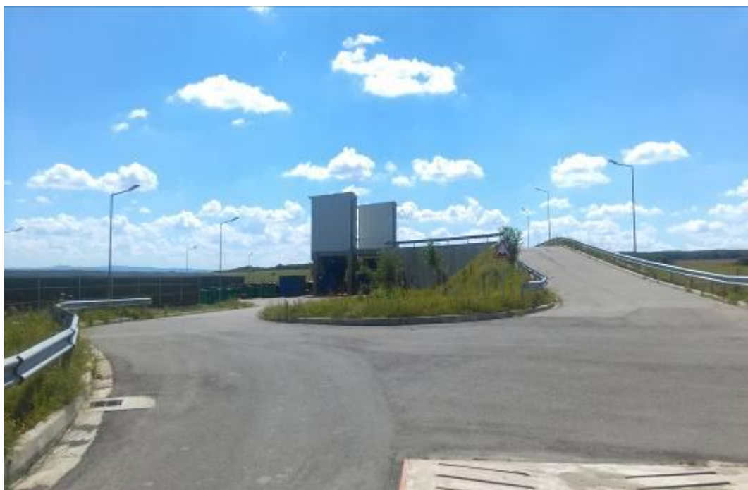
Fig. VII.1.7. Stația de transfer deșeuri din Crasna
