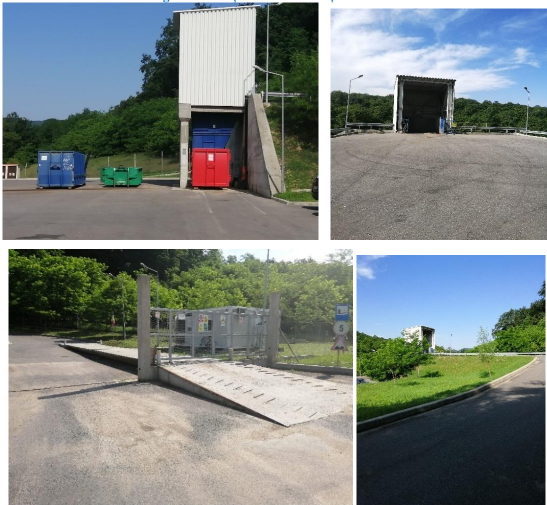
Figura 4-8 Stația de transfer deșeuri Surduc
