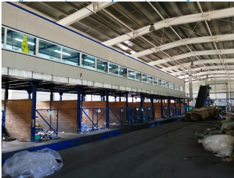
Figura 4-12 Stația de sortare pentru deșeurile menajere Dobrin
