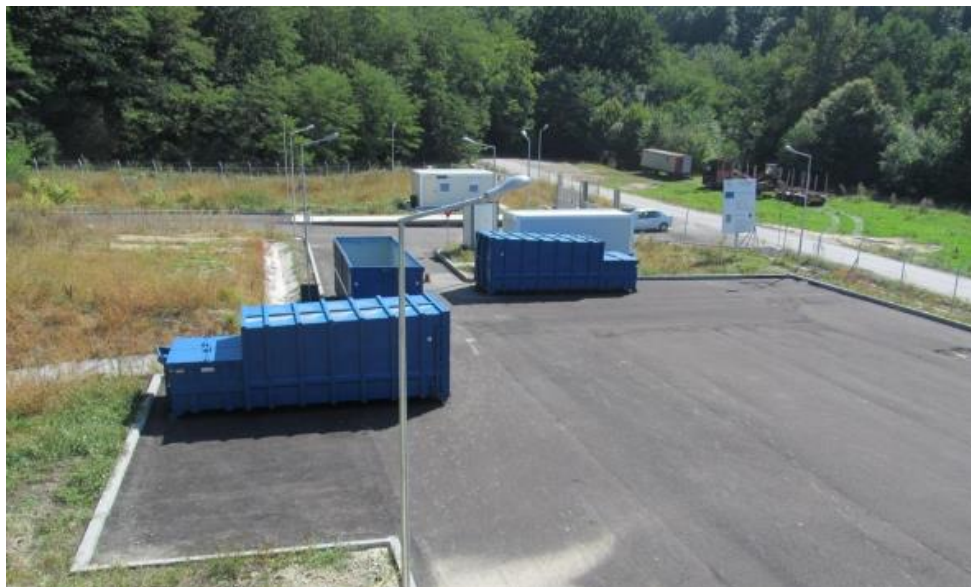
Figura 4-9 Stația de transfer deșuri Sânmihaiul Almașului
