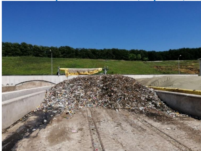
Figura 4-15 Platforma pentru tratarea aerobă (compostarea) a deșeurilor
