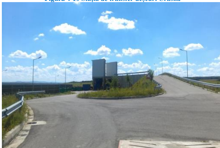
Figura 4-10 Stația de transfer deșuri Crasna
