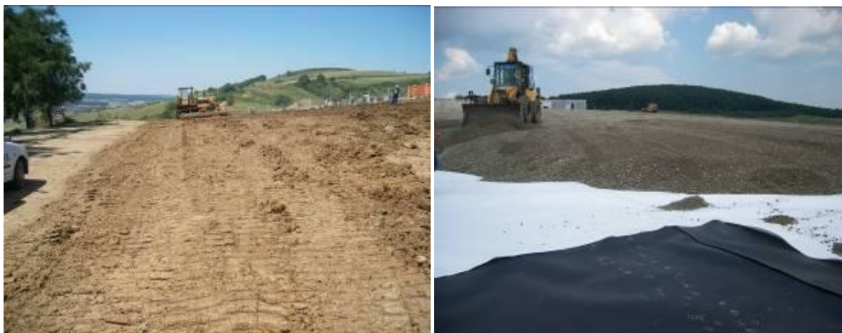
Fig.VII.1.4. Depozit în faza de închidere
