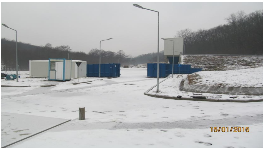
Fig.VII.1.6. Stația de transfer deșeuri din Surduc
