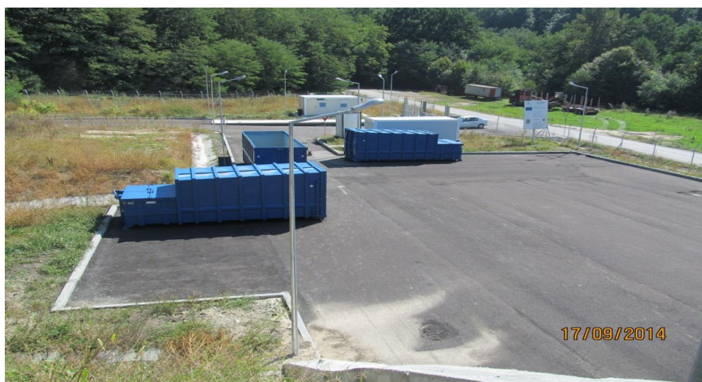
Fig.VII.1.7. Stația de transfer deșeuri din Sânmihaiu Almașului
