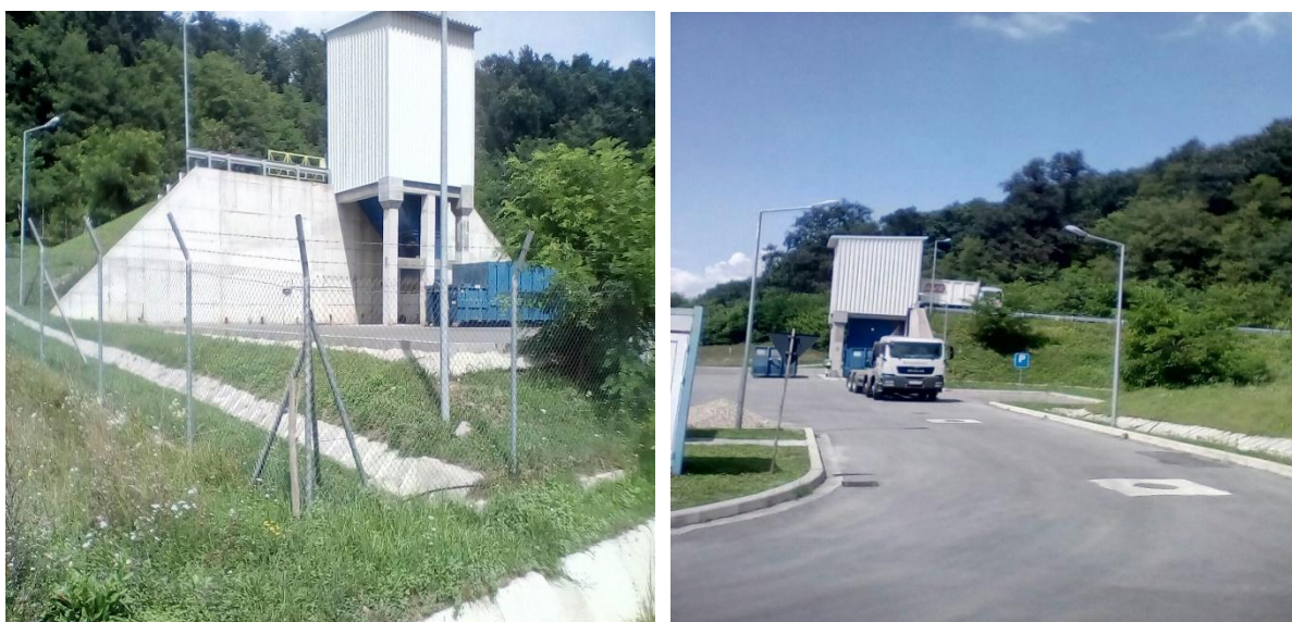
Fig.VII.1.6. Stația de transfer deșuri din Surduc
