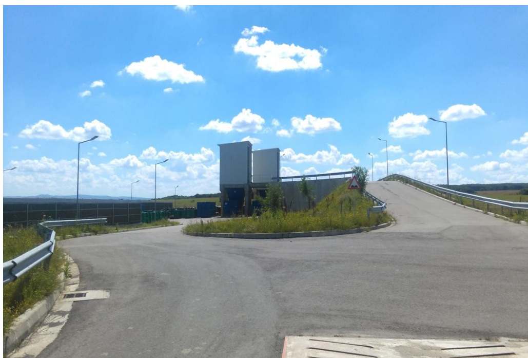
Fig.VII.1.8. Stația de transfer deșeuri din Crasna
